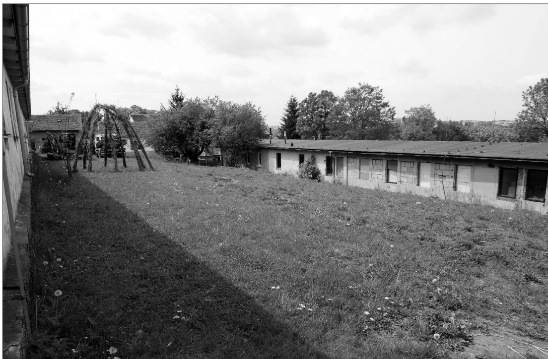
Obrázek č. 15: Přízemní bungalovy používané na výuku na ZŠ Waldorfská Jinonice
